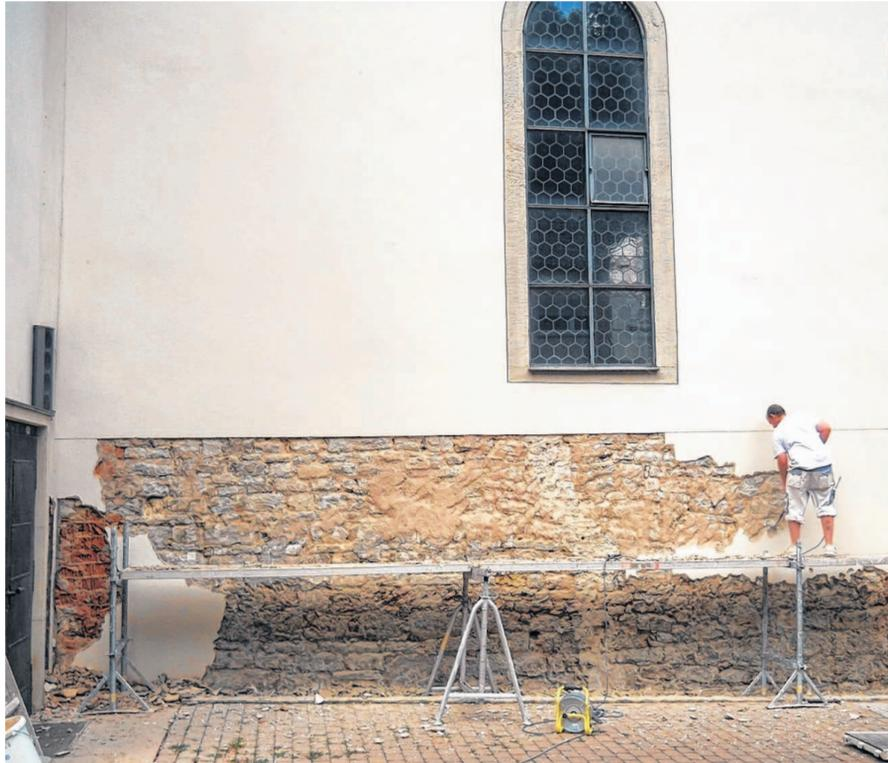
Der Sockelbereich ist an der Außenfassade der Oberlaudaer Kirche durch aufsteigende Feuchtigkeit und Versalzung teilweise deutlich schadhaft. Der Außenputz wird deshalb zurzeit abgenommen, allerdings nicht auf der gesamten Höhe. BILD: SCHATTMANN
